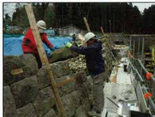
復旧作業状況（左：伝統工法に基づく石積みの施工状況、右：一部に導入した現代工法の施工状況）
